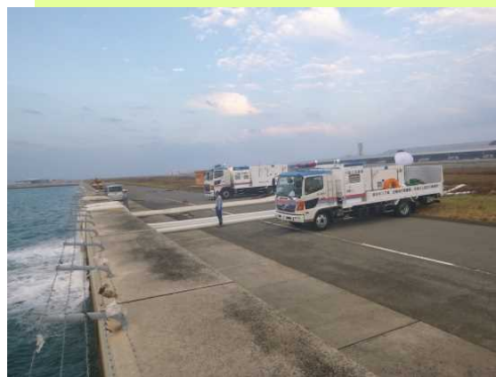
排水ポンプ車による排水作業【平成30年9月 台風21号】
