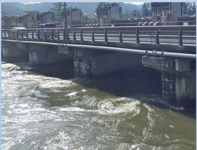
全開放流中の瀬田川洗堰
