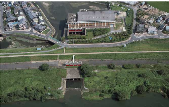
1基あたりの排水量は30mmリ/秒、エンジン出力は、2,800PSと縦方向に羽根車が付いている大型の排水機場です。
