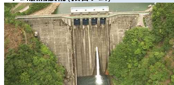
新宮川水系の洪水調節、発電等を目的とした重力式ダムです。(ダム高:74m)
