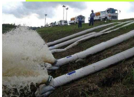
排水ポンプ車による排水作業【平成27年9月関東・東北豪雨】
