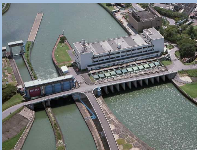
毛馬排水機場
