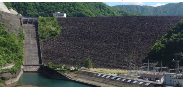
九頭竜川水系の洪水調節、発電等を目的としたロックフィルダムです。(ダム高:128m)
