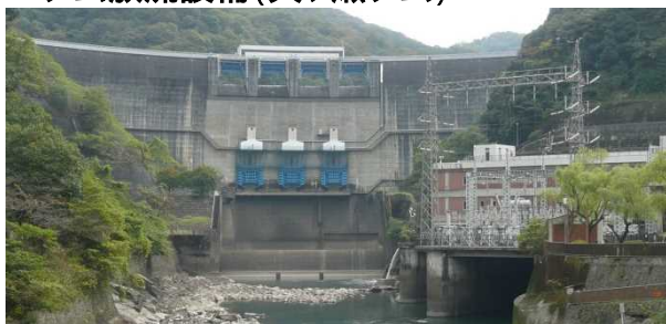
淀川水系の洪水調節、発電等を目的としたアーチ式ダムです。(ダム高:73m)
