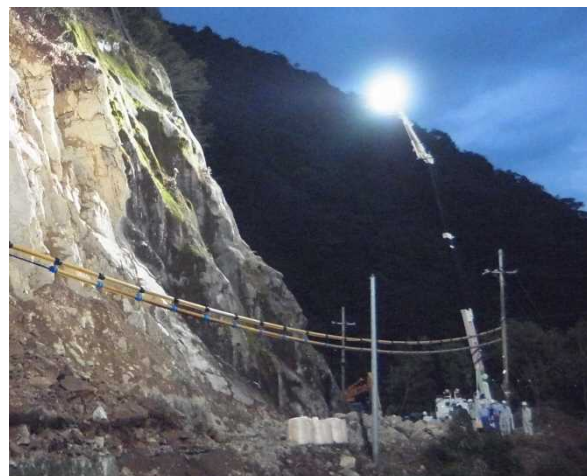
夜間作業を照らす照明車
