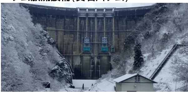
九頭竜川水系の洪水調節、発電等を目的としたアーチ式ダムです。(ダム高:127.5m)
