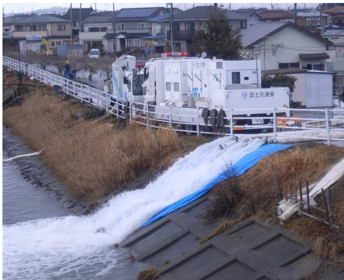
排水ポンプ車による排水作業
