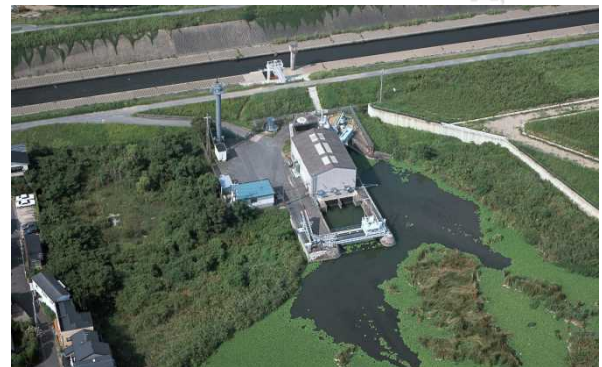
1基あたりの排水量は3mmリ/秒の横縦方向に羽根車が付いている小型の排水機場です。
